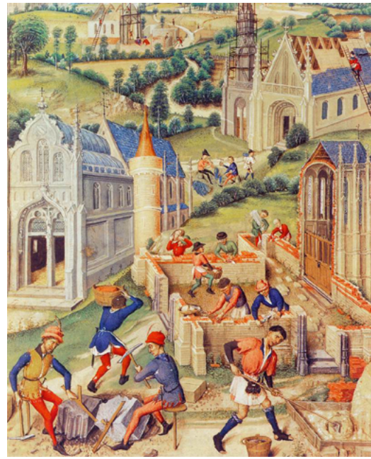
Construcció d'una nova ciutat a França al segle XIV, on començaren evidentment amb les esglésies. Els treballadors probablement eren pagesos pobres que cercaven guanyar-se la vida en la construcció. [ Fig. 364 ]
